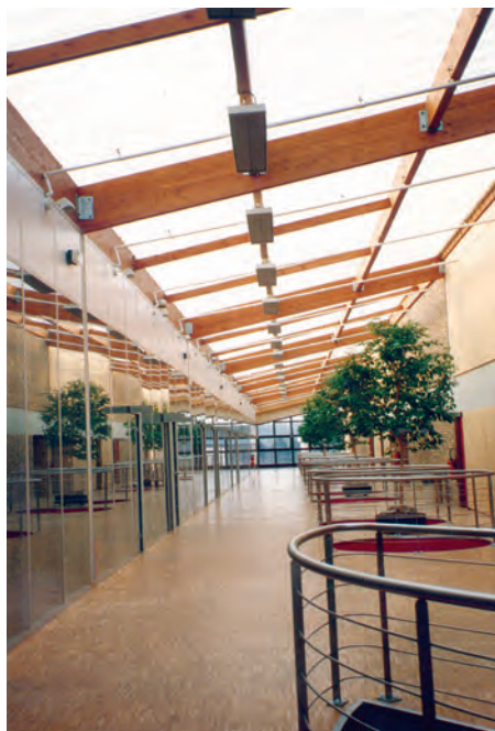
Ogrzewanie korytarzy może być trudne, ale montowany pod sufitem promiennik EZ100 dostarcza ciepło tam, gdzie jest potrzebne.
