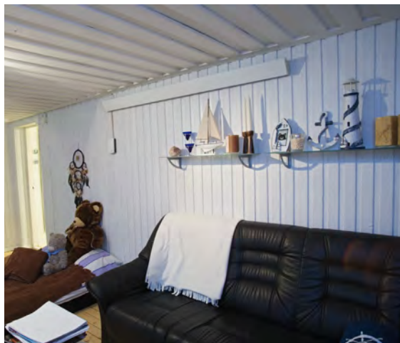
Promienniki THERMOPLUS zamontowane na połączeniu ściany i sufitu zajmują minimum miejsca.
