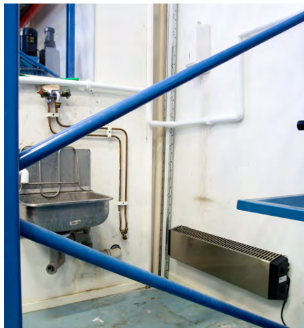
W wersji ze stali nierdzewnej, konwektor THERMOWARM może być używany w środowiskach korozyjnych.
