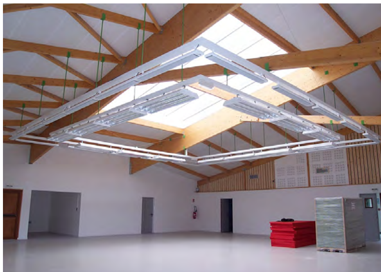
Budynki używane sporadycznie można szybko ogrzać bez wysokiego zużycia energii. Promienniki EZ100 doskonale komponują się z oświetleniem elektrycznym.
