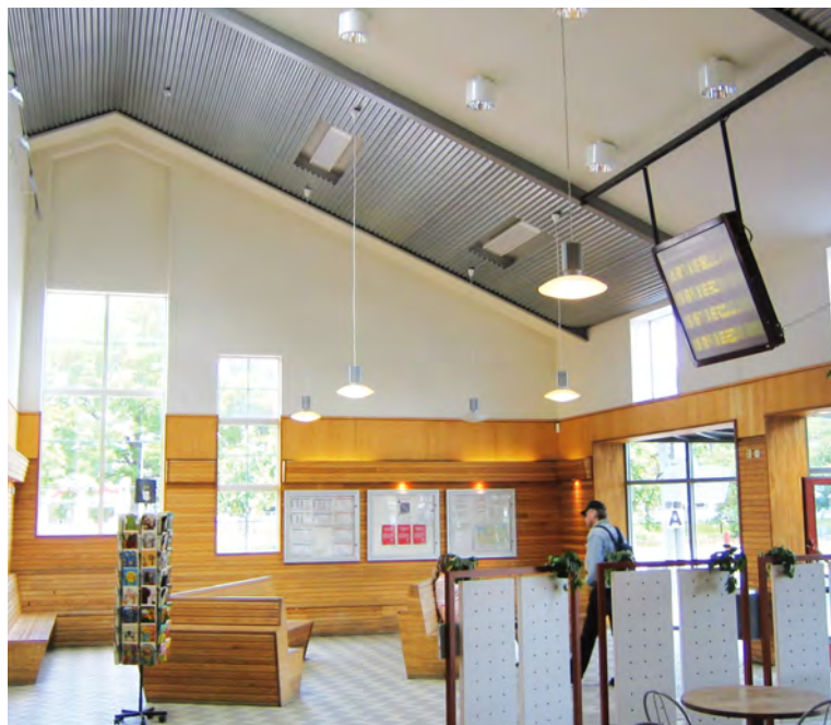
Urządzenia EZ100 zamontowane pod sufitem nie będą szpecić ładnych, pokrytych boazerią ścian.
