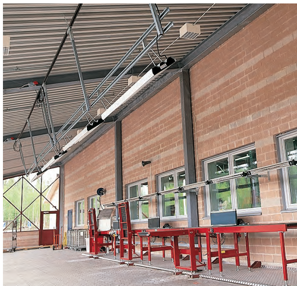
Promienniki IR można zamontować pod kątem, kierując ogrzewanie tam, gdzie jest potrzebne. Promienniki używane na zewnątrz należy umieścić pod dachem. W tym przypadku stanowiska pracy są ogrzewane przez promienniki IR w suficie oraz promienniki CIR na ścianie.
