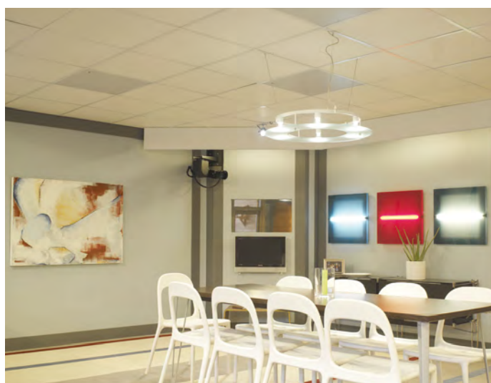
Po zamontowaniu promiennika kasetonowego w suficie podwieszanym powstaje przyjemne i niemal niewidoczne ogrzewanie. Promienniki kasetonowe można łatwo przenosić w przypadku zmiany umeblowania.
