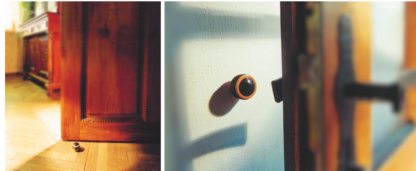
Die Türstopper haben eine Doppelfunktion. Sie können sowohl am Boden als auch an der Wand montiert werden. / The door stoppers can be mounted on the floor as well as on the wall.
