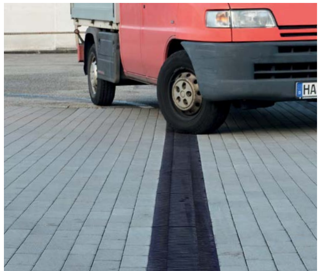
Zabudowa w nawierzchni brukowej
