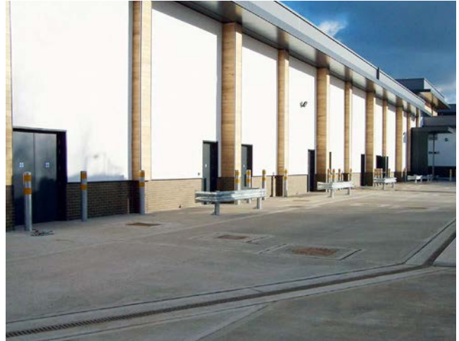
Zabudowa w nawierzchni betonowej
