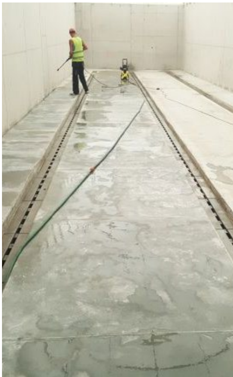
Zakład unieszkodliwiania odpadów Katowice AS-S100 N-0 - 4020 mb
