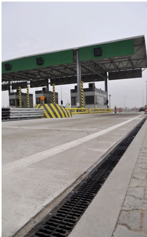
Autostrada A2 Buk AS-150
