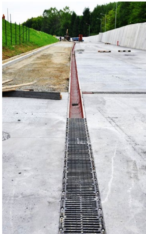
Składowisko Odpadów Komunalnych Barycz AS-300 - ponad 700mb
