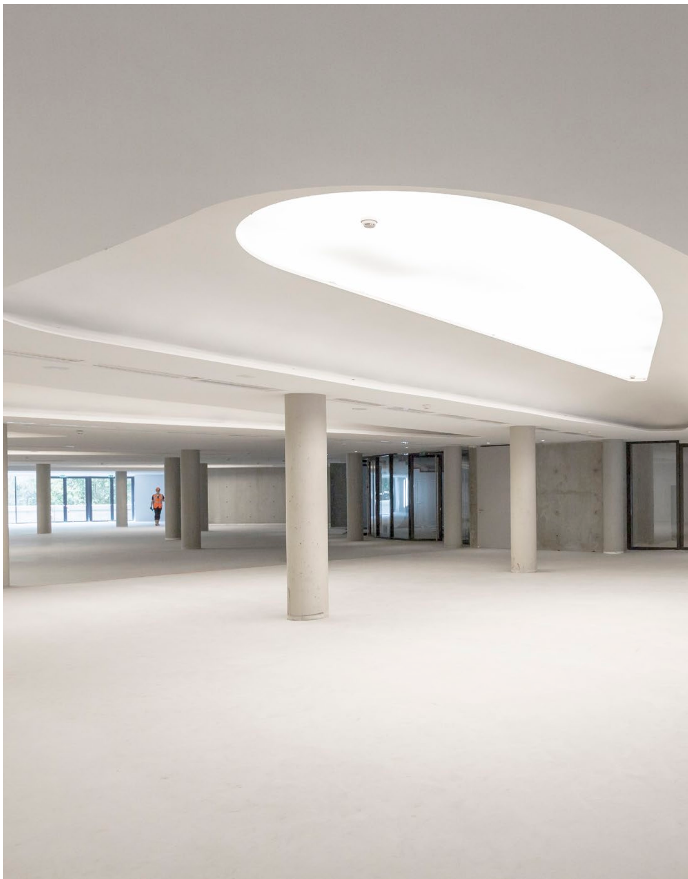
Projekt: Cité de la Musique, Paryż, Francja / Montaż: SERTAC Sufit: Rockfon® Mono® Acoustic / Zdjęcie: Laurent Blossier
