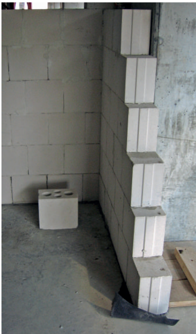
Fotografia 3. Połączenie ściany wypełniającej wzdłuż krawędzi dolnej z konstrukcją
