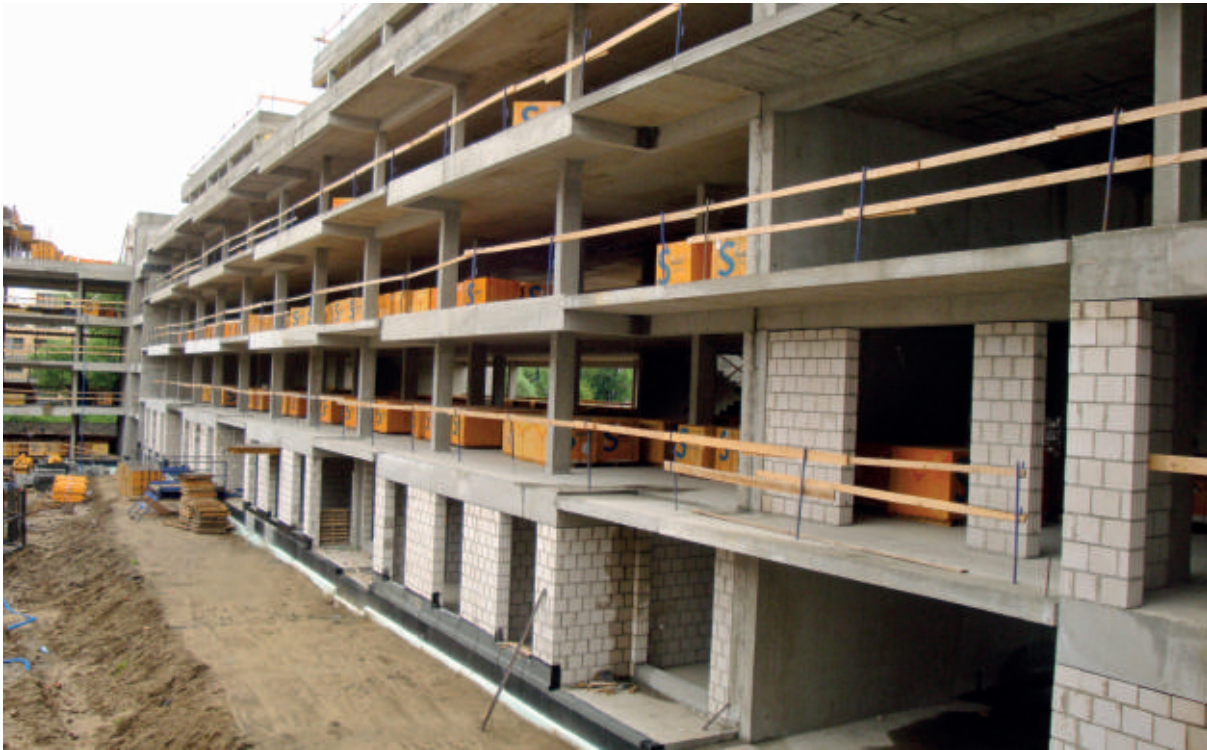
Fotografia 2. Ściany wypełniające w budynku mieszkalnym (stan surowy otwarty)
