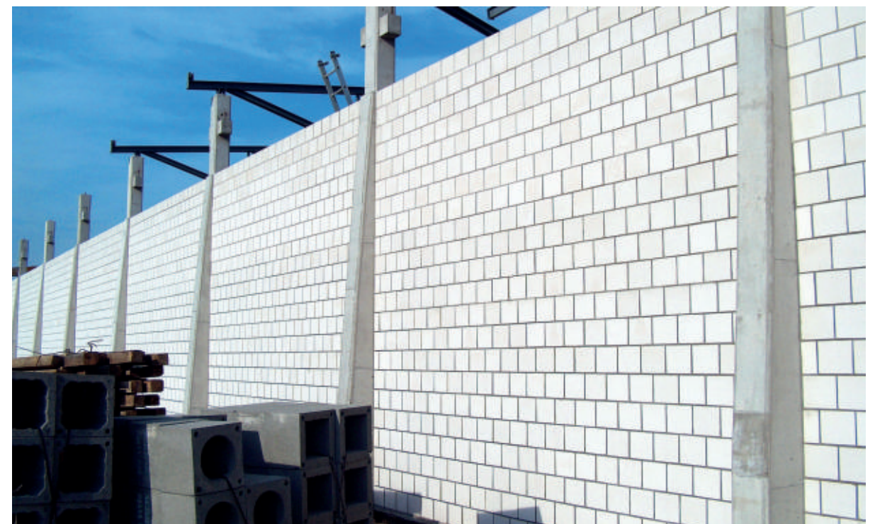
Fotografia 1. Nieotynkowane ściany wypełniające w budynku halowym (fotografia wykonana podczas wznoszenia obiektu)
