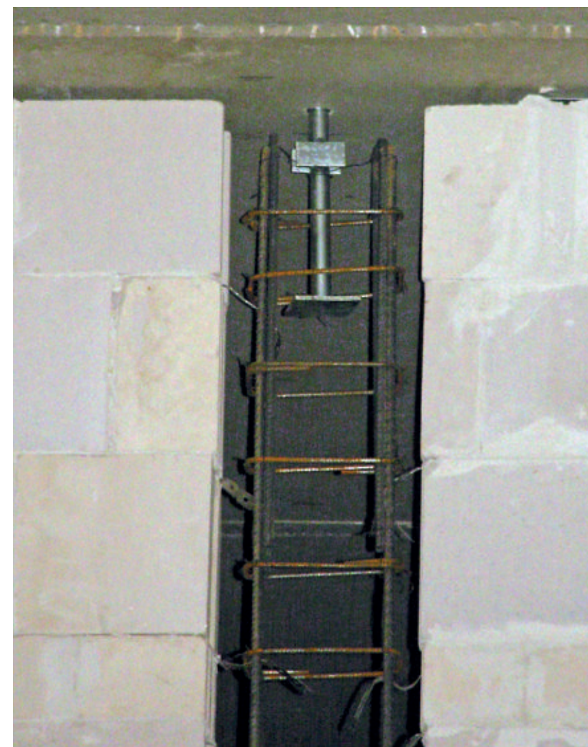
Fotografia 5. Widok łącznika KL200 przed zabetonowaniem rdzenia
