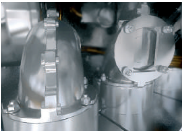
Zintegrowane zawory klapowe zwrotne.
