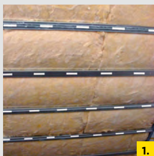
1. Przyklejanie taśmy ISOVER Vario® XtraPatch do profili metalowych.
