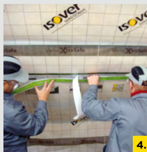
4. Zaklejenie zakładów folii taśmą ISOVER Vario® XtraTape.
