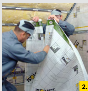
2. Przycinanie na wymiar folii ISOVER Vario® XtraSafe, korzystając ze znaczników.
