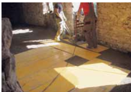
Pomysłowy sposób przemieszczania się i zagęszczania kruszywa.
