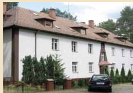
Budynek po remoncie.
