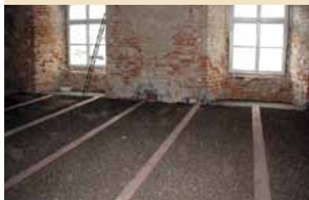
Keramzyt ułożony na płytach WPS.
