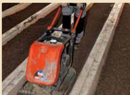
Zagęszczanie keramzytu pomiędzy belkami.
