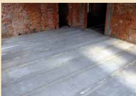
Strop po wykonaniu szprycu na keramzycie.
