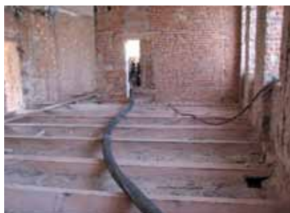
Strop przed układaniem keramzytu.
