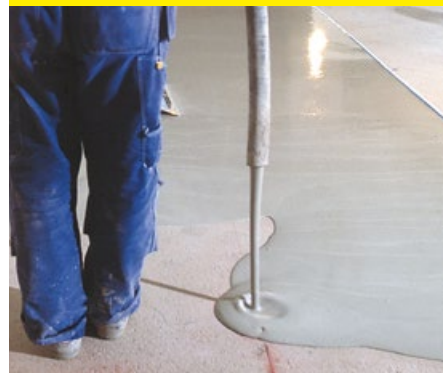
Zaprawa w workach układana przy użyciu pompy
