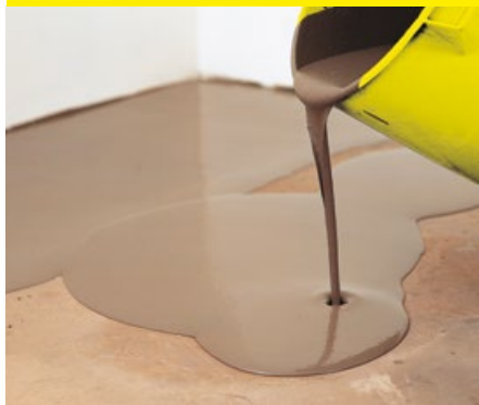
Zaprawa w workach układana ręcznie
