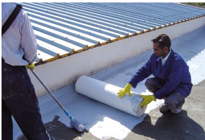
7. Układanie tkaniny technicznej weber.dry fabric szer. 100 cm, pasami z zakładem 5-10 cm.
