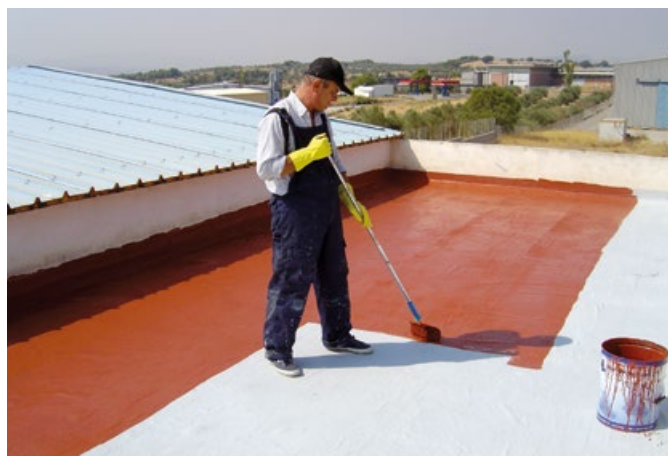
10. Nakładanie warstwy wykończeniowej (jednej lub dwóch weber.dry PUR coat (lub weber.dry PUR coat traffic ).
