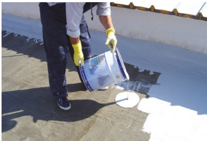
6. Nanoszenie pierwszej warstwy membrany poliuretanowej weber.dry PUR seal na powierzchnię dachu.
