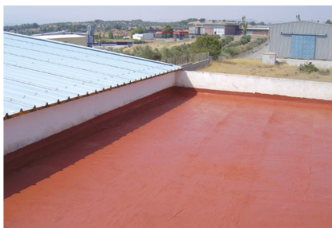
11. Gotowe pokrycie dachu systemem poliuretanowych membran uszczelniających weber.dry PUR System .
