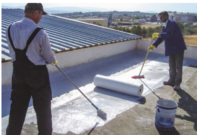
8. Wtapienie tkaniny technicznej weber.dry fabric w warstwę weber.dry PUR seal .
