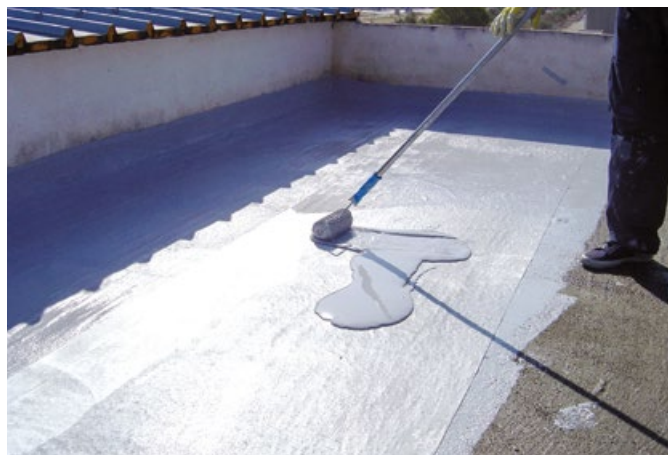
9. Nakładanie kolejnej warstwy (zamykającej) weber.dry PUR seal .
