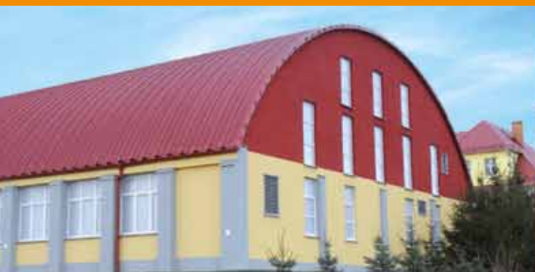
Hala sportowa w Marcinowicach z układem GEO-KLIMAT
