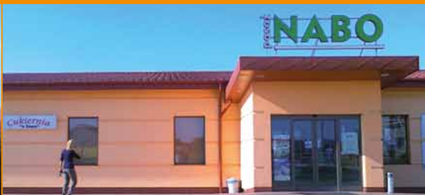
Pasaż Handlowy w Koninie – GWC 3500 GEO współpracujący z centralą grzewczo-wentylacyjną GEO-VENT 3000
