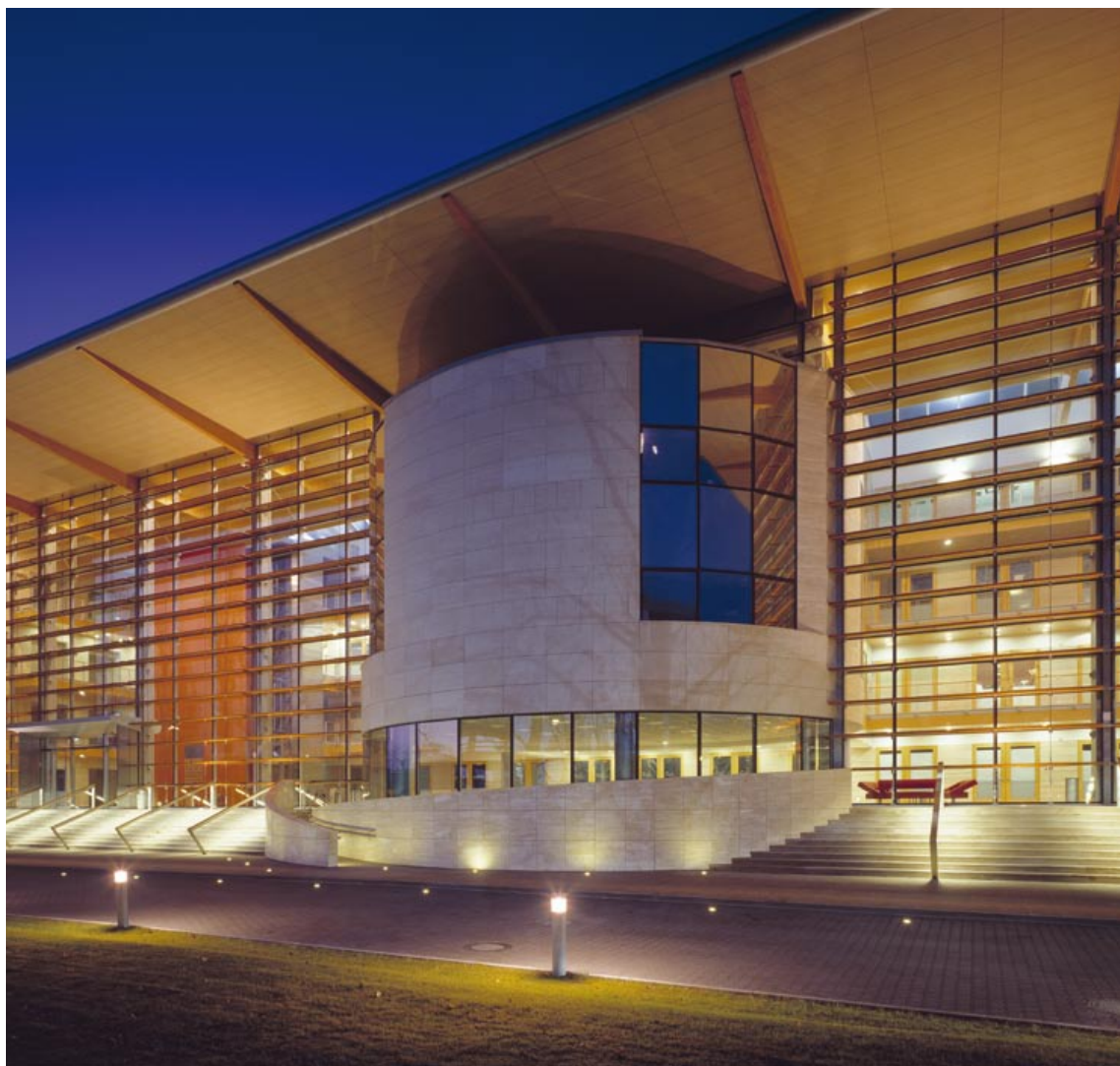
Biurowiec Tulipan House, Warszawa - szyby zespolone Pilkington Insulight™ Sun i Pilkington Insulight™ Protect
