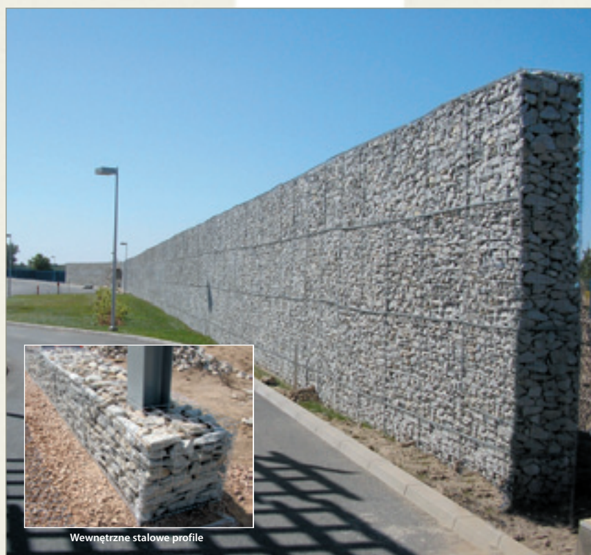
Wolnostojąca ściana gabionowa, ze wspornikami wewnętrznymi, przy fabryce Gillette w Łodzi. Polska - 2005 rok.
