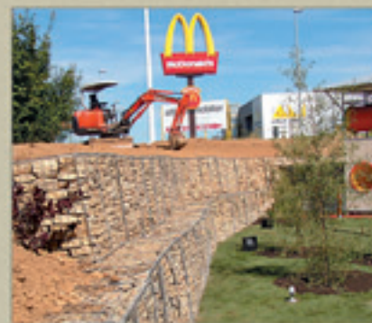
McDonalds, Chantier, Francja - 2004 rok.
