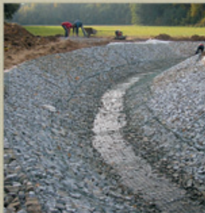
Wyłożenie przepustu, Autostrada A4, Krzywa, Polska - 2005 rok.
