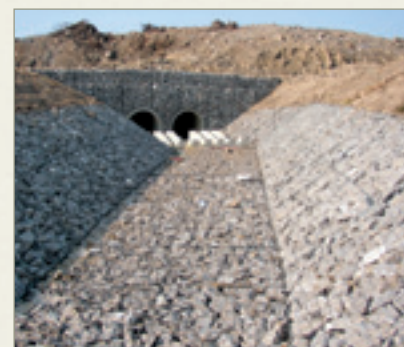
Wyłożenie przepustu z wykorzystaniem materacy przy A465 na wyjeździe z Valley Road, Południowa Walia - 2004 rok.
