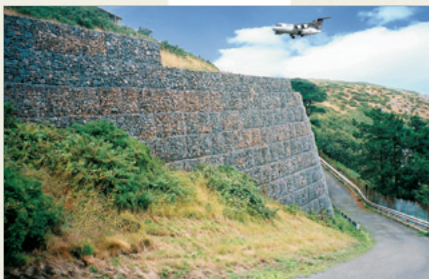
19 metrowa ściana grawitacyjna z gabionów zbudowana w roku 1968 na terenie lotniska Jersey na wyspach Kanalu La Manche.
