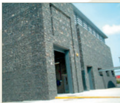
Okladzina budynku stacji oczyszczania i uzdatniania wody w Duncrue, Belfast, Nowa Irlandia - 2004 rok.
