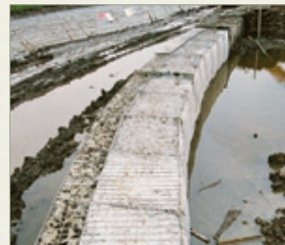
Konstrukcje przeciwpowodziowe z Bastionów wypełnionych betonem, Collier Street, Szczecin – 2001 rok.
