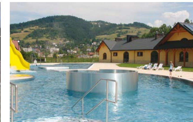
BASEN STALOWY, CENTRUM REKREACYJNO-SPORTOWE W MUSZYNIĘ
