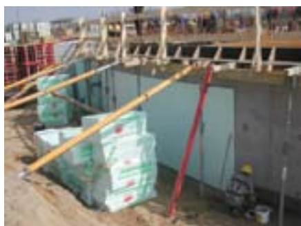
Izolacja ściany fundamentowej
