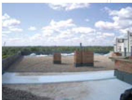
Izolacja dachu płaskiego
