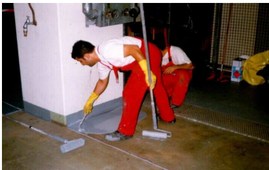
Aplikacja żywic epoksydowych
