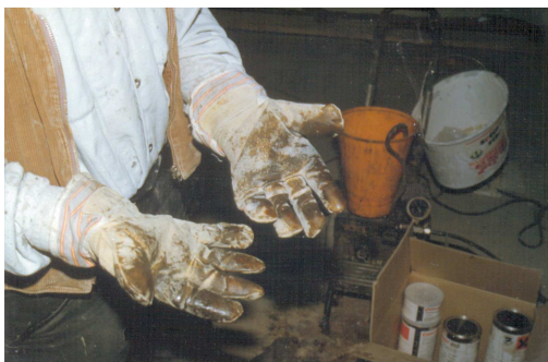
Tak nie należy postępować! Przesiknięte żywicą epoksydową rękawice skórzane
