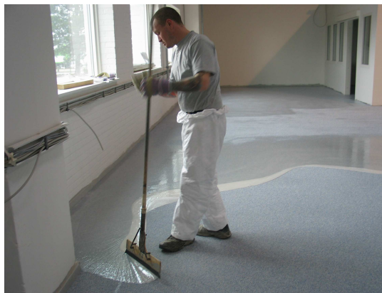
Rozpraszanie żywicy przy pomocy wycieraczki gumowej z długą rączką
