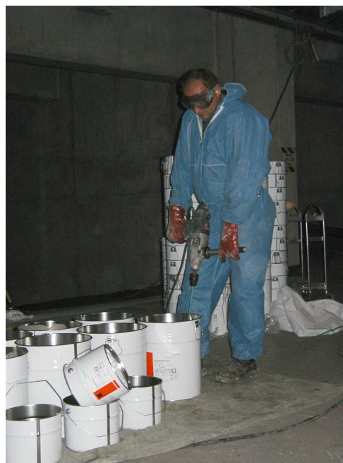
Mieszanie żywicy epoksydowych
