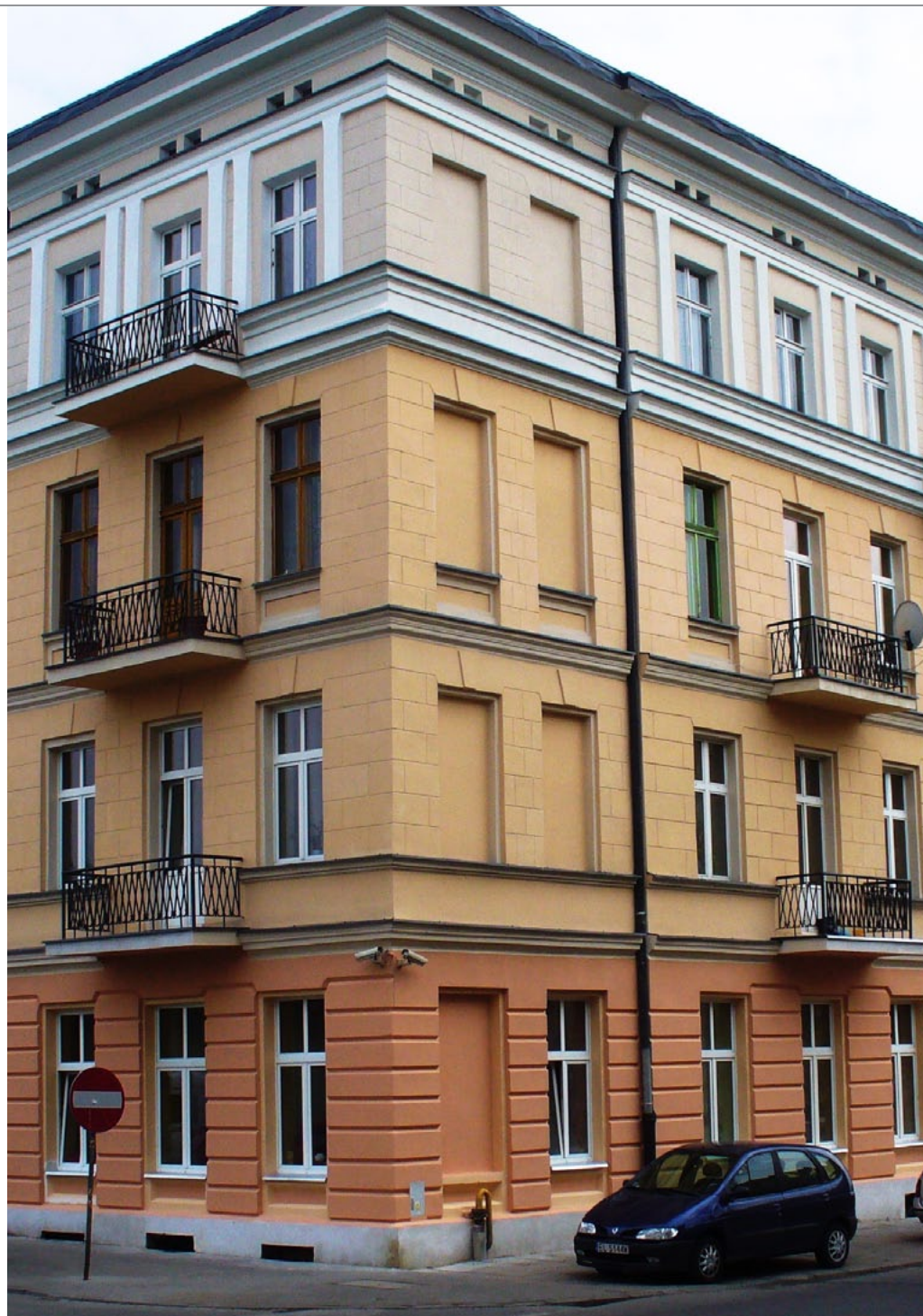
NA ELEWACJI ODTWARZANE BYŁY CZĘŚCI GZYMSÓW, OPASEK OKIENNYCH I WSZYSTKIE BONIOWANIA ŚCIAN NA PARTERZE.
