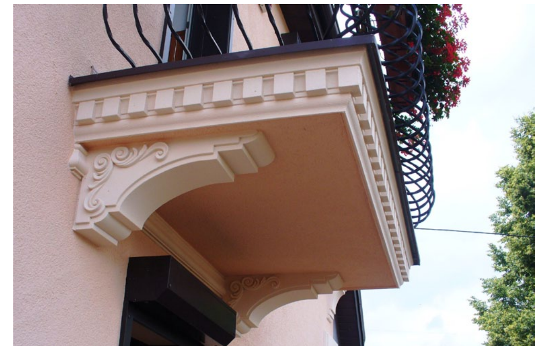
BALKON – WYKONALIŚMY GZYMS Z KOSTKĄ, PODPORĘ BALKONU I LISTWY
