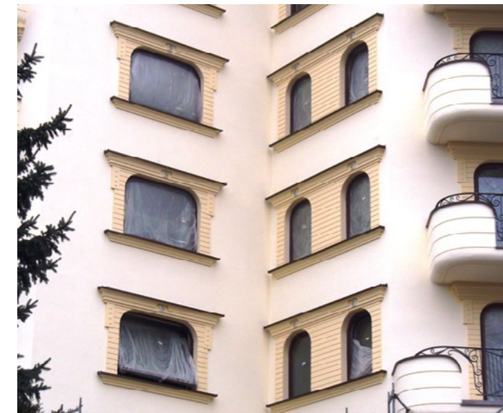
APARTAMENTOWIEC W WARSZAWIE PRZY ULICY SUŁKOWICKIEJ 2, GDZIE WYKONALIŚMY ELEMENTY OZDOBNE OKIEN, PODPARAPETNIKI I NADOKIENNIKI. INDYWIDUALNYM ROZWIĄZANIEM SĄ TAM BALKONY O ZAOKRĄGLONYCH KSZTAŁTACH.
