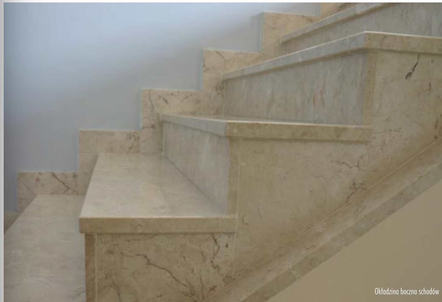
Schody zabiegowe — stopnie o nieregularnych kształtach i wymiarach
