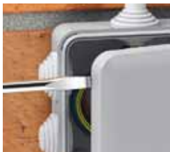
Zdejmowanie zatrzaskowej pokrywy
