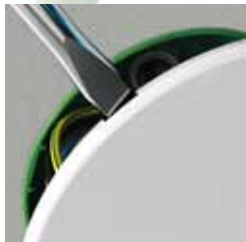
Usuwanie zatrzaskowej pokrywy puszki rozgałęźnej
