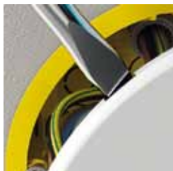
Usuwanie zatrzaskowej pokrywki puszki rozgałęznej
