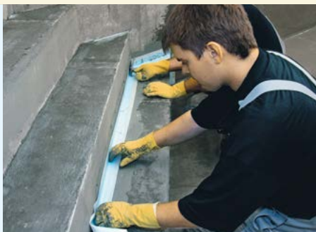
Wklejenie taśmy uszczelniającej PCI Pecitape® 120 w świeżo naniesione uszczelnienie PCI Seccoral®.
