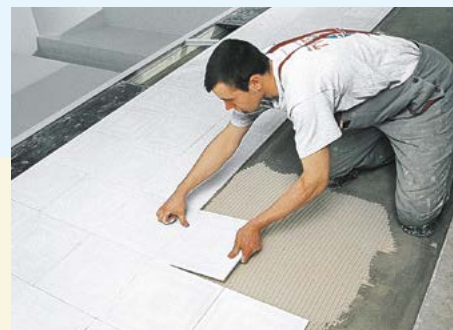
Wyklejanie wielkoformatowej ceramiki za pomocą PCI Nanolight®.
