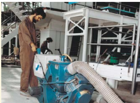
Bezpyłowe przygotowanie dna niecki basenowej przez blastrakowanie.
