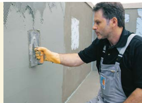
Wyrównanie powierzchni ścian niecki szpachlą betonową PCI Polycrét® 5 (1 - 5 mm), zaprawą wyrównawczą PCI Pericrét® (3 - 20 mm) lub lekką zaprawą naprawczą PCI Nanocrét® 100.
