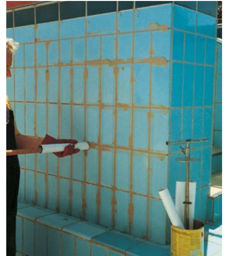
Starsze spoiny cementowe, które są uszkodzone, można ponownie zaspoinować zaprawą PCI Durapox® NT/NT plus. Wystarczy przy tym głębokość spoiny wynosząca co najmniej 3 mm.
