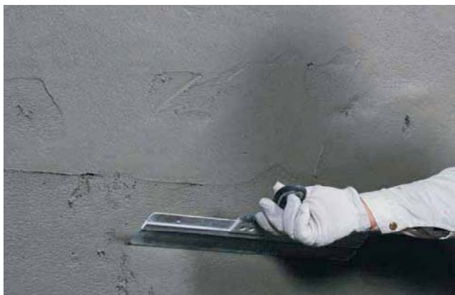
Wyrównywanie nierówności za pomocą tynku odcinającego PCI Saniment® DP
