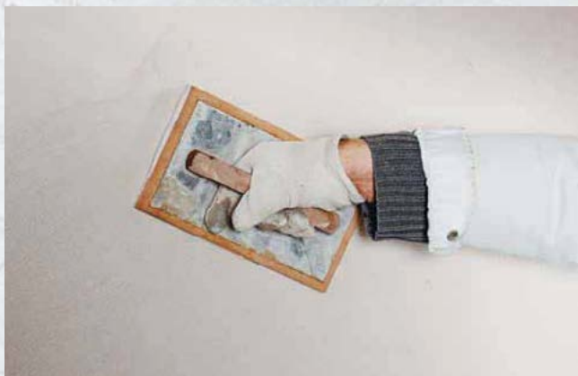
Wygładzenie powierzchni ściany za pomocą tynku drobnoziarnistego PCI Saniment® FP
