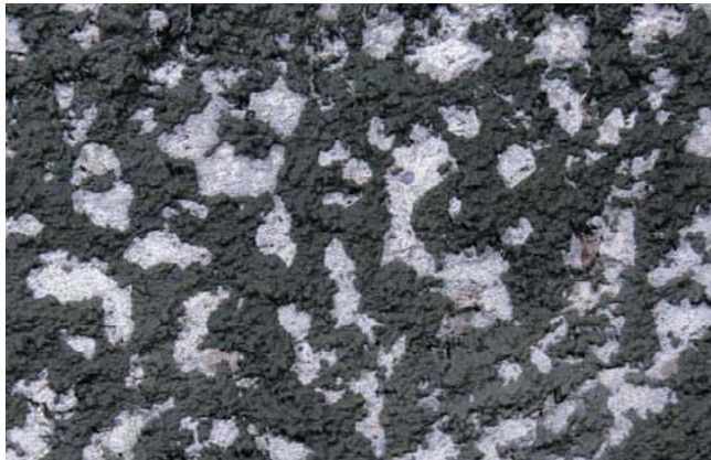
Przygotowanie podłoża za pomocą obrzutki PCI Saniment® HA
