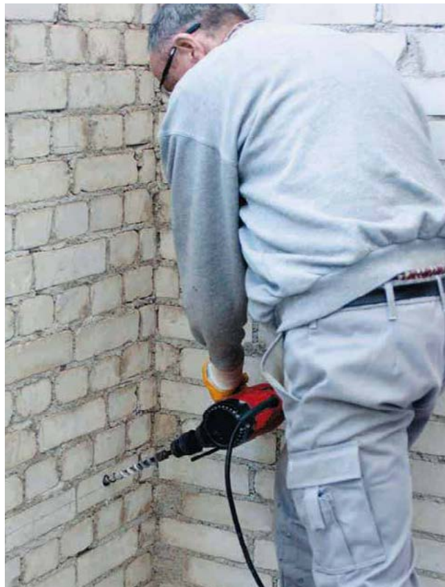
Przygotowanie otworów w celu wykonania uszczelnienia poziomego (przepony poziomej).
