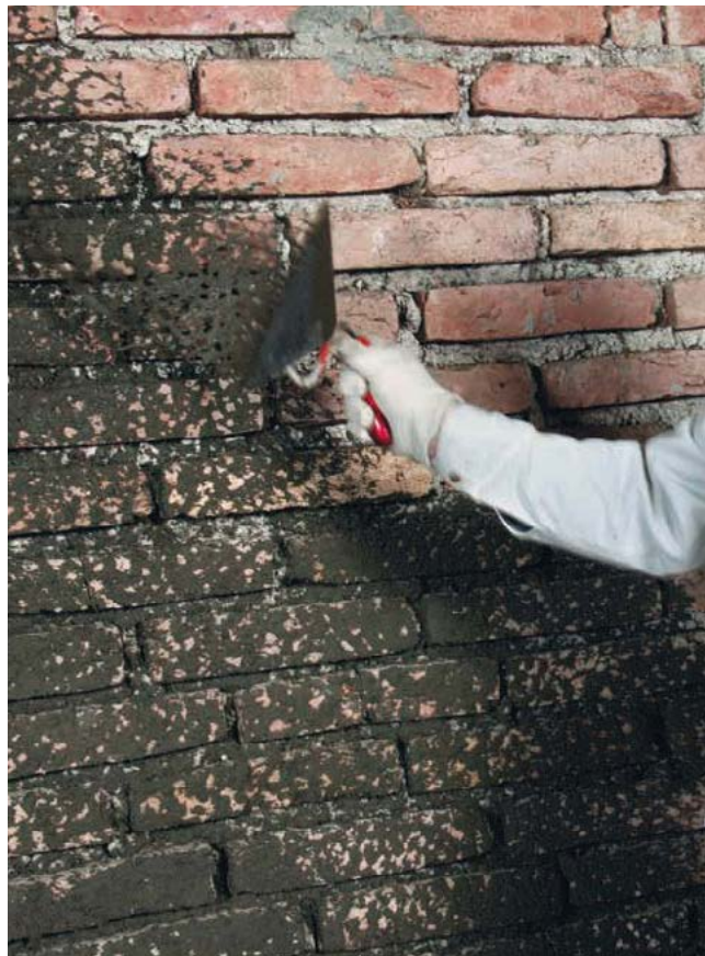
Nanoszenie sieciowej obrzutki PCI Saniment® HA za pomocą kielni trójkątnej
