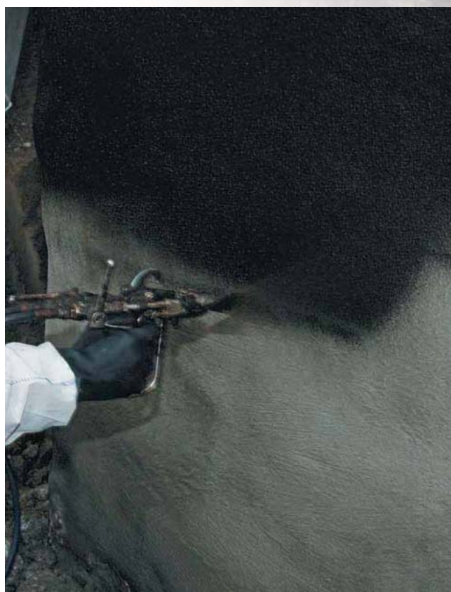
Nanoszenie środka gruntującego PCI Pecimor® F na ścianę zewnętrzną piwnicy przed wykonaniem uszczelnienia za pomocą bitumicznej powłoki grubowarstwowej.
