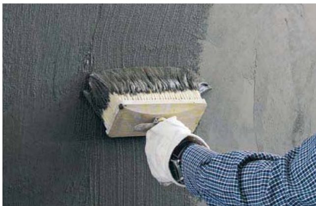
Wykonanie uszczelnienia przed wilgocią wnikałą za pomocą szlamu uszczelniającego PCI Saniment® DS
