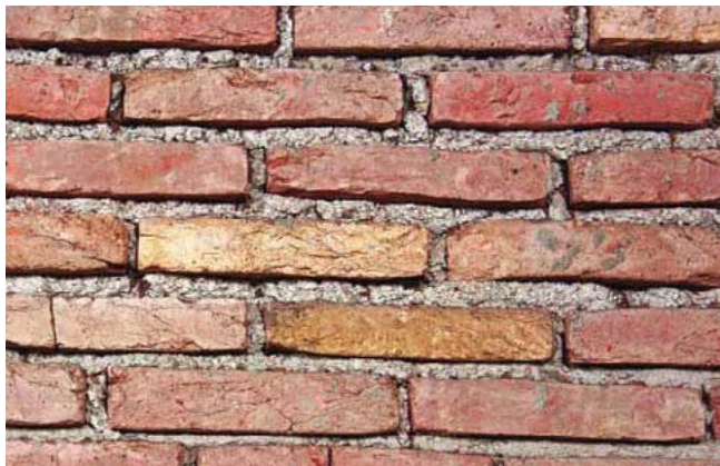
Mur nierówny, oczyszczony
