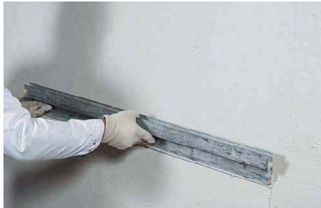
Użycie jednowarstwowego, odpornego na działanie siarczanów tynku renowacyjnego PCI Saniment® Super
