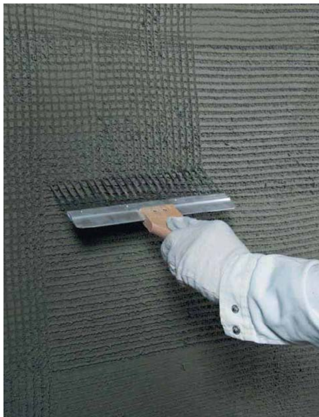
Uszorstnienie tynku odcinającego PCI Saniment® DP za pomocą grzebień tynkarskiego przed нанесением тynку реновационного
