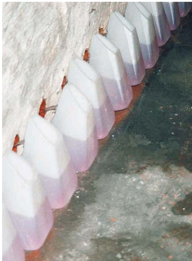
Wykonanie uszczelnienia poziomego (przepony poziomej) poprzez iniekcję bezciśnieniową przy użyciu uszczelniacza iniekcyjnego PCI Bohrlochsperre.
