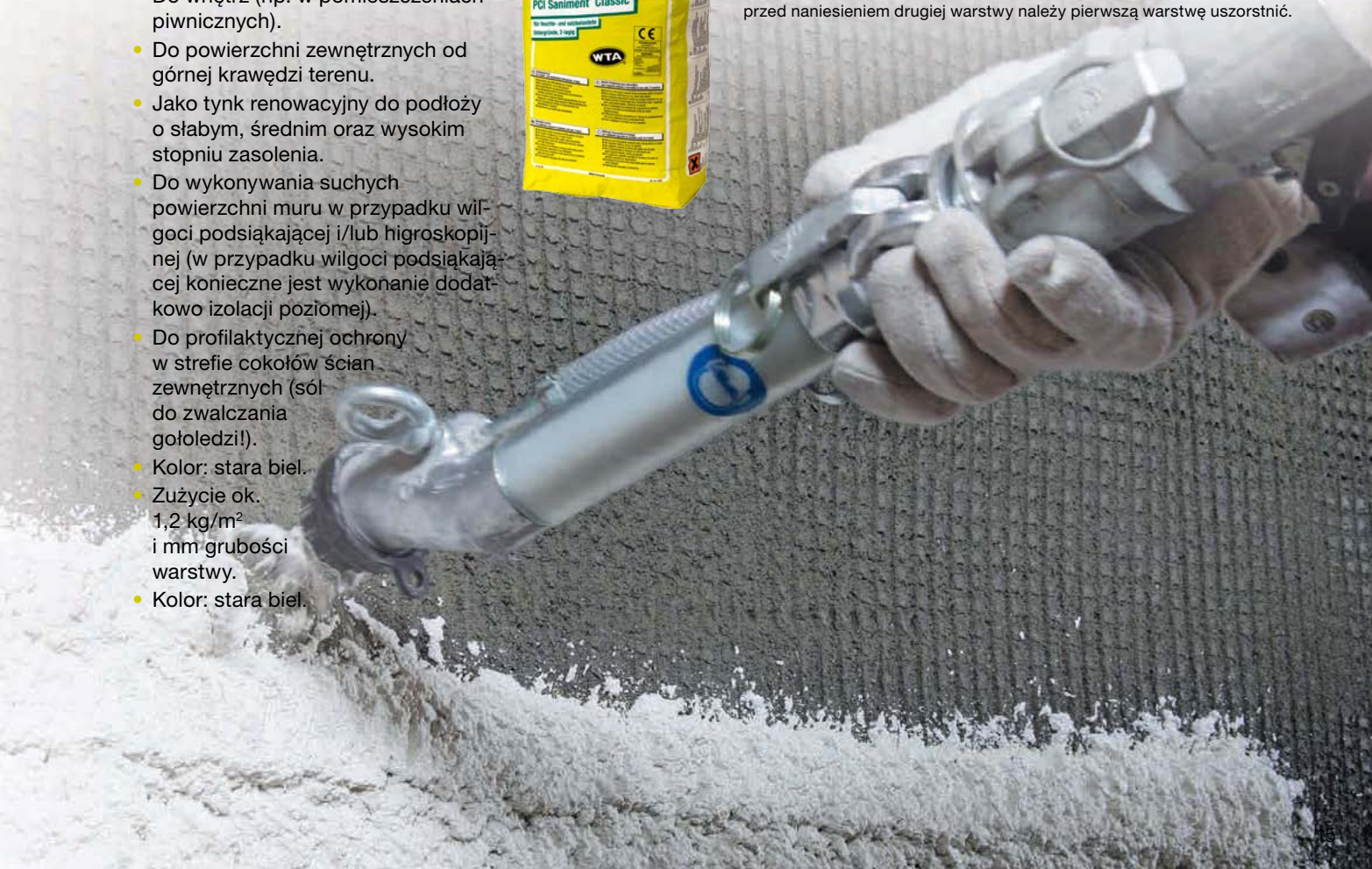
Użycie dwuwarstwowego tynku renowacyjnego PCI Saniment® Classic: przed naniesieniem drugiej warstwy należy pierwszą warstwę uszorstnić.
