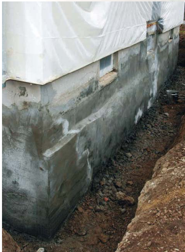
Odsłonięta i wyrównana ściana zewnętrzna piwnicy przed wykonaniem powierzchniowego uszczelnienia zewnętrznego
