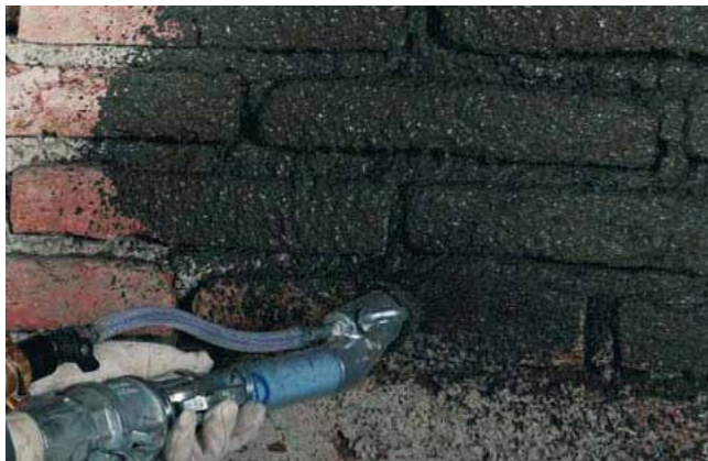
Przygotowanie podłoża poprzez narzucenie obrzutki PCI Saniment® HA przed wyrównaniem nierówności
