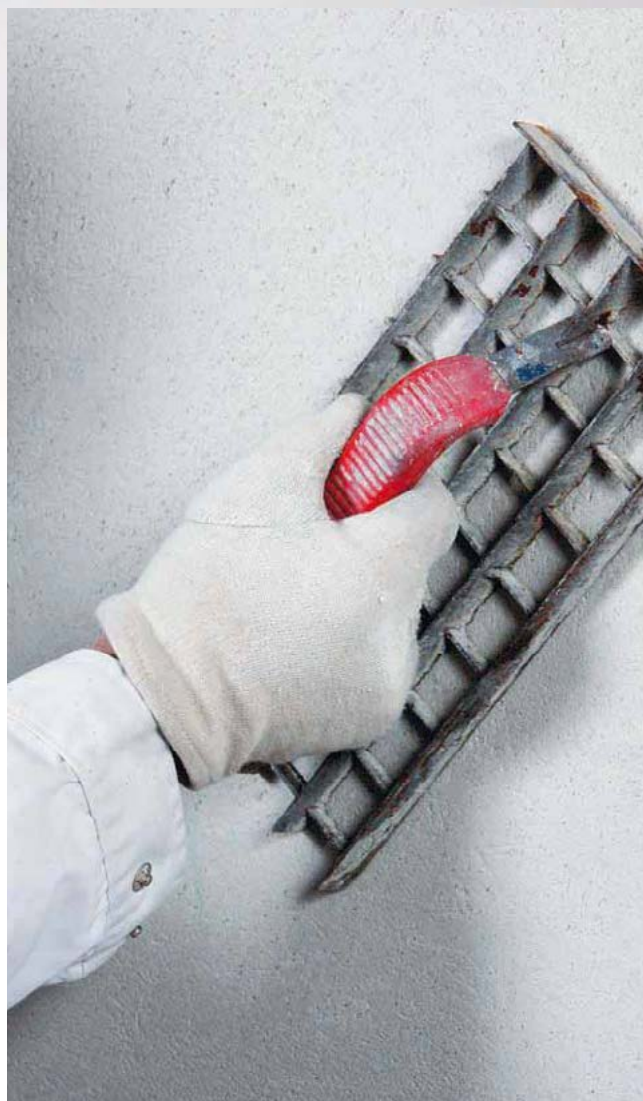
Przygotowanie powierzchni tynku renowacyjnego PCI Saniment® Super za pomocą pacy kratkowej przed naniesieniem tynku cienkowarstwowego PCI Saniment® FP.
