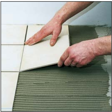
wyklejanie na elektrycznym ogrzewaniu podłogowym
