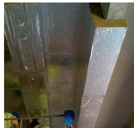
Ocieplenie spodu trybun Stadionu Narodowego
