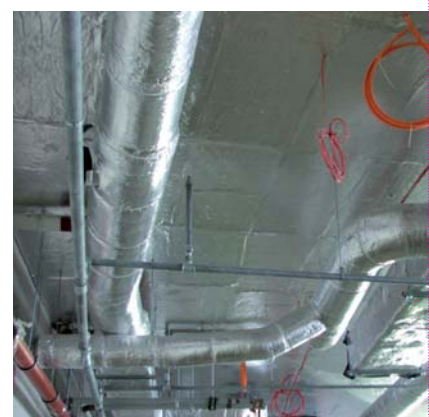
Wykonany system MultiTherm® HSV na stropach pomieszczeń technicznych
