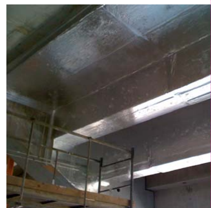
Ocieplenie podciągu systemem MultiTherm® HSV
