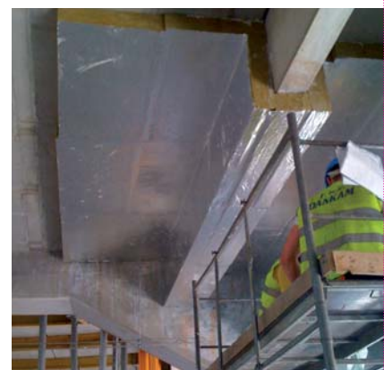
Ocieplenie spodu trybun Stadionu Narodowego
