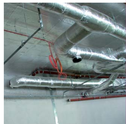
Wykonany system MultiTherm® HSV na stropach pomieszczeń technicznych
