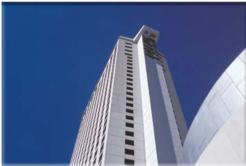
Obiekt: Hotel i kasyno Palms Miejsce: Las Vegas (Nevada), USA Zakres prac: Zewnętrzna izolacja + wykończenia BASF
