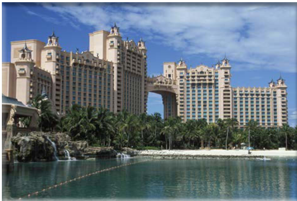
Obiekt: Hotel Atlantis Miejsce: Nassau, Wyspy Bahama Zakres prac: Zewnętrzna izolacja + wykończenia BASF
