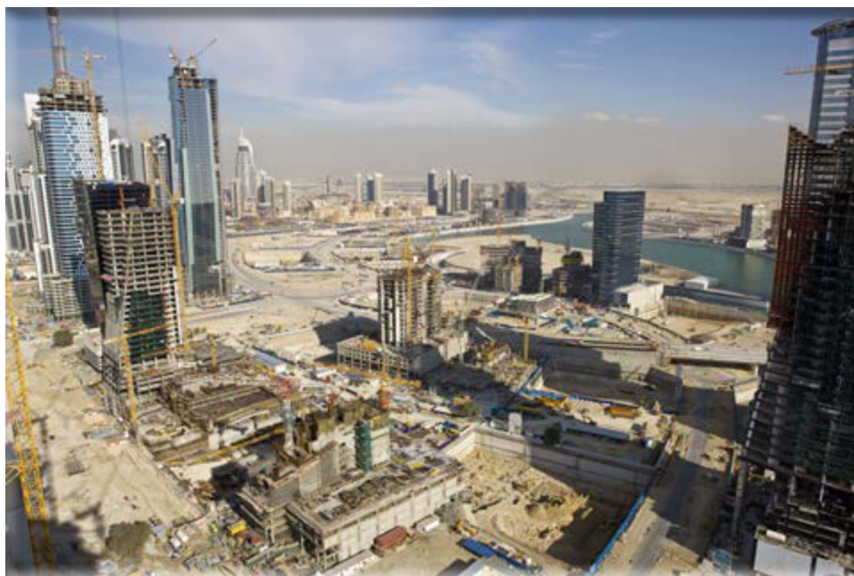
Obiekt: Dubaj – centrum w budowie Miejsce: Dubaj, Zjednoczone Emiraty Arabskie Zakres prac: W Emiratach mówi się, że jest tam największe stężenie żurawi budowlanych na świecie... i to jest prawda, a jednym z największych dostawców technologii i produktów budowlanych jest dział Construction Chemicals koncernu BASF.
