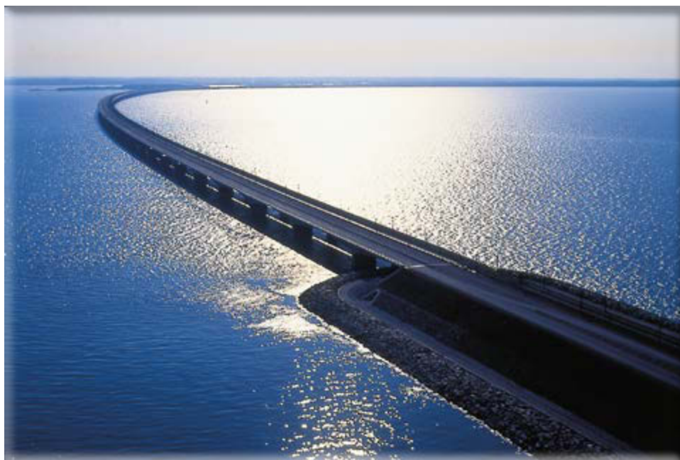
Obiekt: Great Belt Bridge Miejsce: Dania Zakres prac: Technologie i produkty BASF działu Construction Chemicals - konkretne mocne i trwałe architektoniczne arcydzieła, nawet w bardzo trudnych warunkach środowiskowych, takich jak na otwartym morzu.
