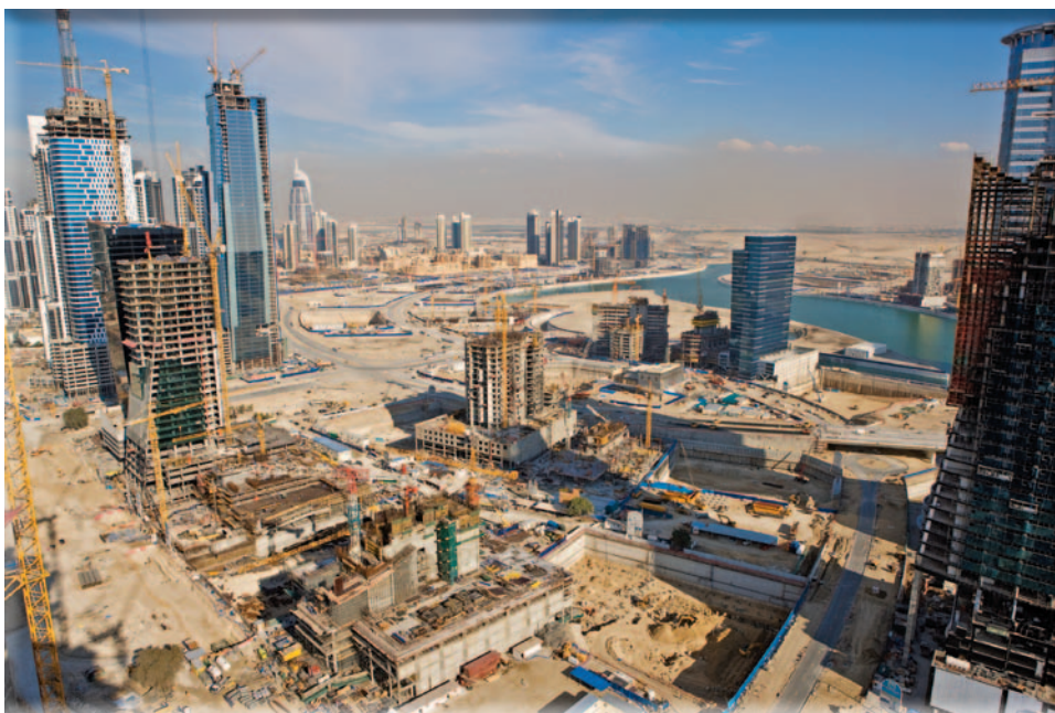
Obiekt: Dubaj – centrum w budowie Miejsce: Dubaj, Zjednoczone Emiraty Arabskie Zakres prac: Centrum Dubaju jest jednym z największych placów budowy na świecie, a produkty BASF znajdują zastosowanie na wszystkich etapach nawet najbardziej wymagających inwestycji budowlanych.
